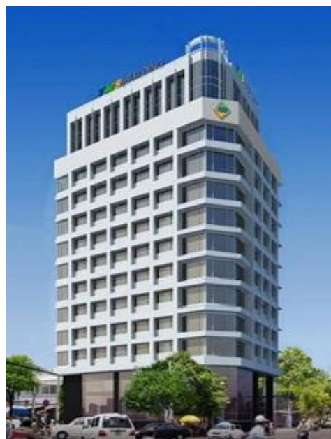
Hình 6 :Tòa nhà TMS|BUILDING
